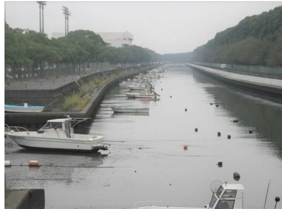
写真-2 裏川係留状況（2019年）
