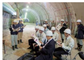
国道212号響峠バイパス（日田市）
