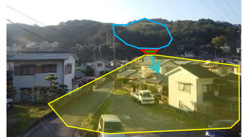
②上流荒廃状況
