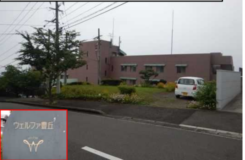
③保全対象 ウェルファ豊丘(福祉避難所)
