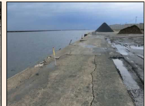
中津港田尻地区
