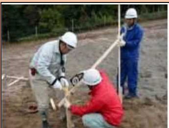
従来施工：丁張確認→施工、繰返し
