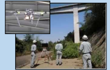
ドローン等を用いた点検
