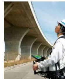
赤外線画像の撮影状況
