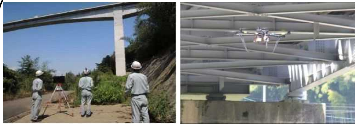
操作状況全景
