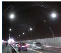
トンネル照明のLED化
