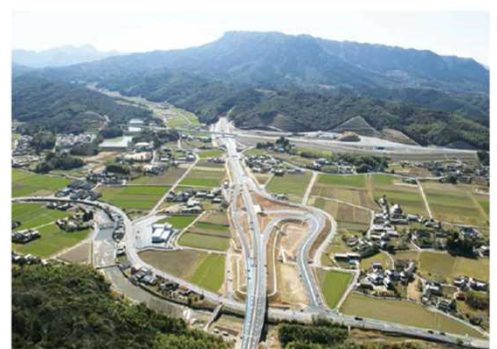
日田に向かって整備が進む中津日田道路
