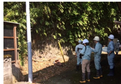
点検実施状況
