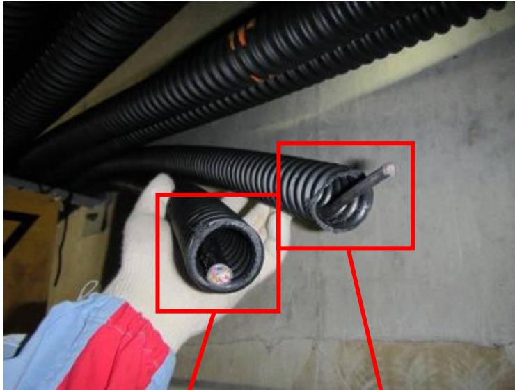
伊方発電所 3号機 火災感知器のケーブル切断箇所復旧写真
