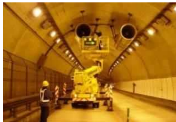
トンネル点検状況
