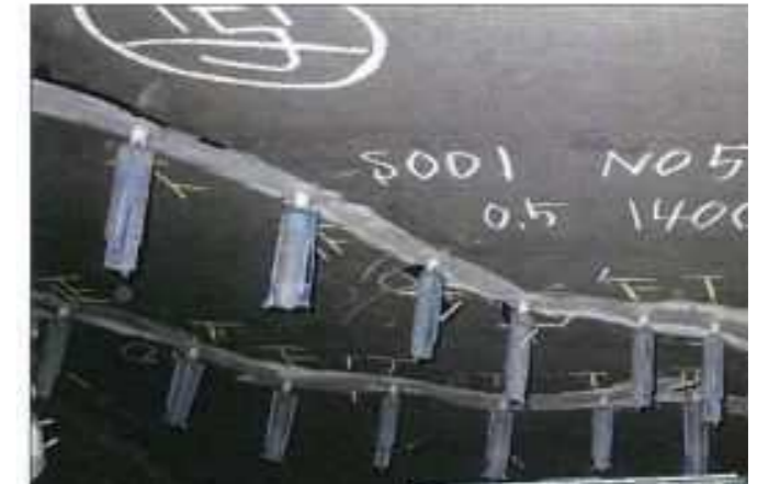
対策：ひび割れに薬剤を注入
