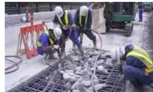
橋梁補修状況（中津市：中津豊前線）
