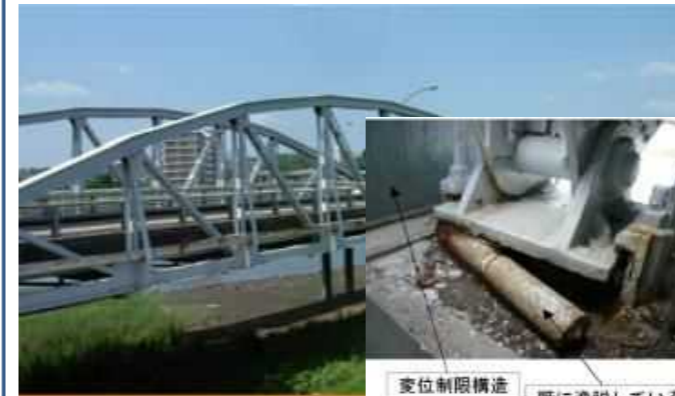
国道197号 乙津橋(大分市) 支承の損傷
