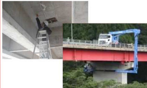
橋梁点検状況
