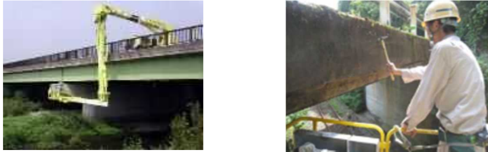
定期点検状況(近接目視・打音検査)
