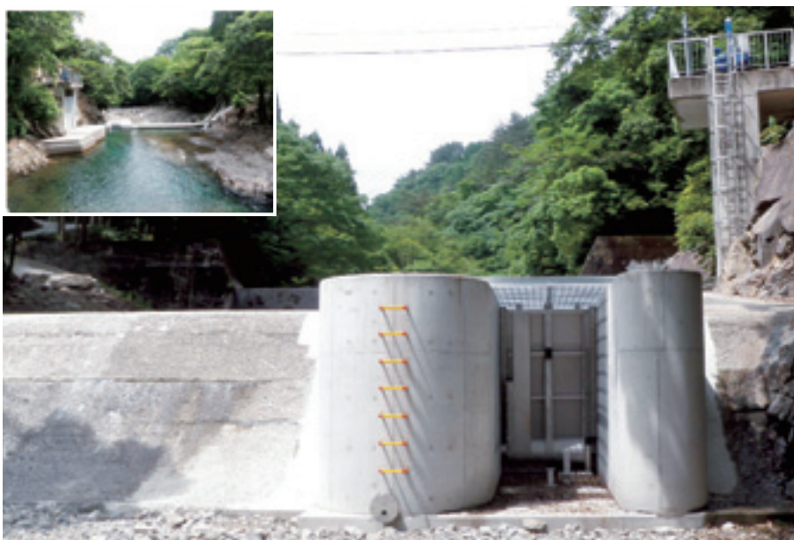
「土砂吐のゲート化で管理効率の向上（長谷緒頭首工）」 中山間地域総合整備事業（豊後大野西部地区）
