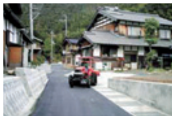
集落道と農道の一体的な整備
