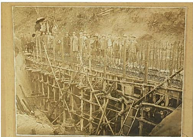
昭和初期の水路橋の改修工事
