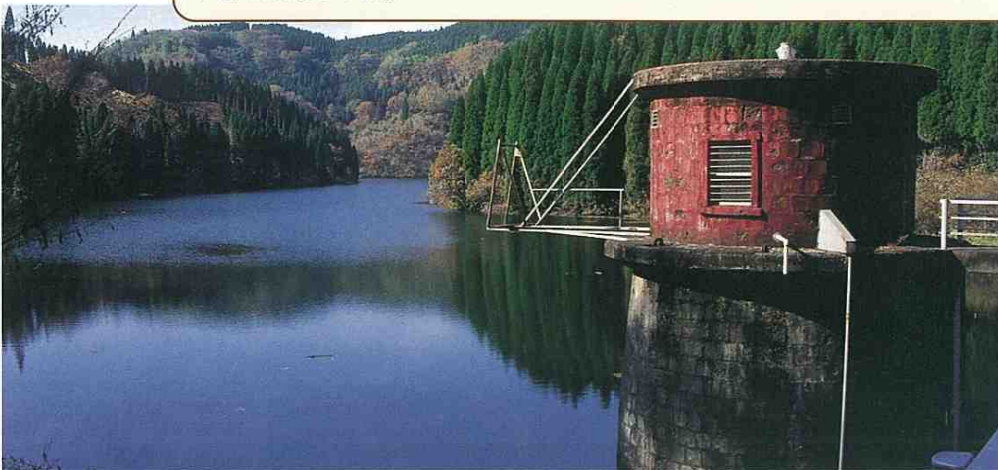
【大谷ダム】～直下に水を取り入れている「轟の滝」がある。
