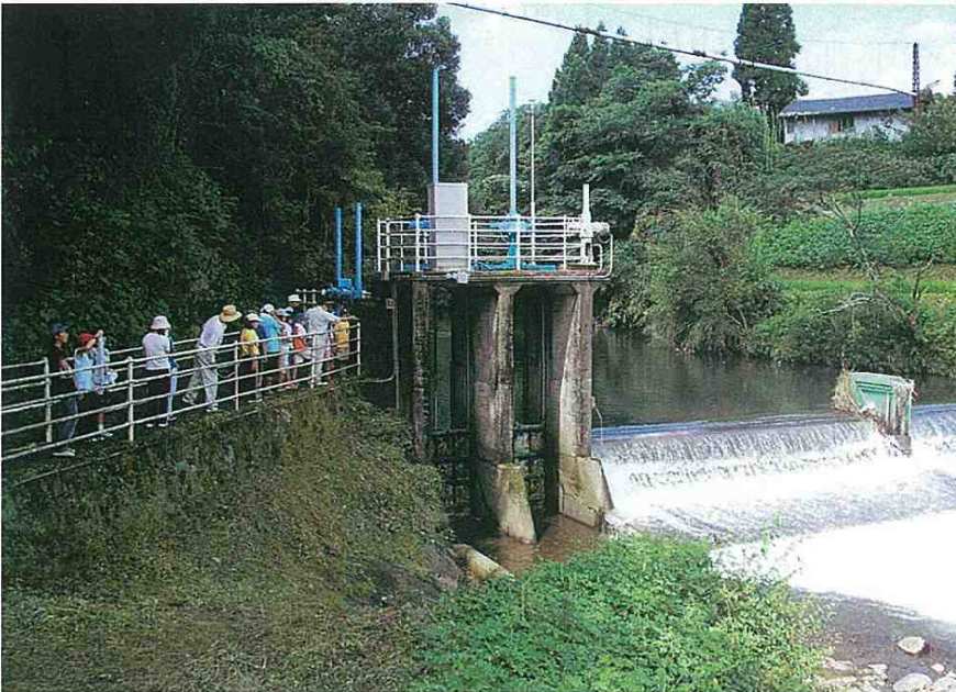
現世利川井路 取入口
