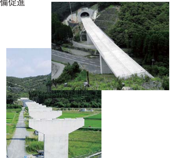
着実に工事が進む東九州自動車道 (佐伯市)
