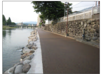
遊歩道整備後
