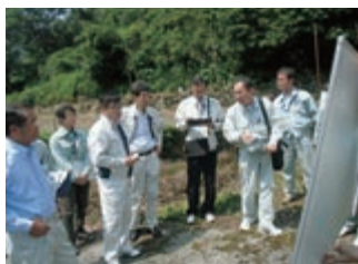
国道212号地震被災箇所(日田市)
