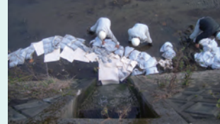
河川に流出した油が流下しないよう作業
