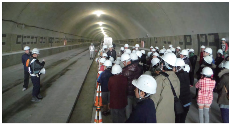
親子と土木のふれあい見学会の開催(東九州自動車道での工事現場見学)
