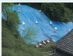
家屋背後の崩壊した斜面を迅速に保護
