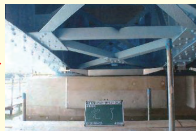
塗装の塗り替えによる橋梁の長寿命化 (国道 388 号美国橋)
