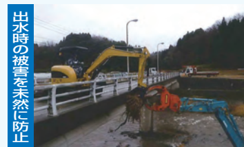
出水時の被害を未然に防止 河川内の流木を除去
