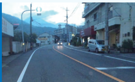
減速路面標示事例
