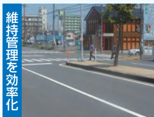
維持管理を効率化 中央分離帯の防草対策
