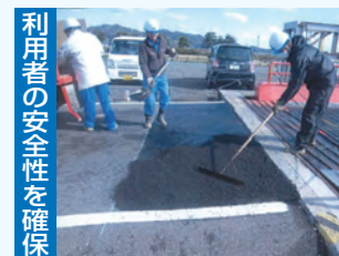
利用者の安全性を確保 フェリー乗入部の段差解消
