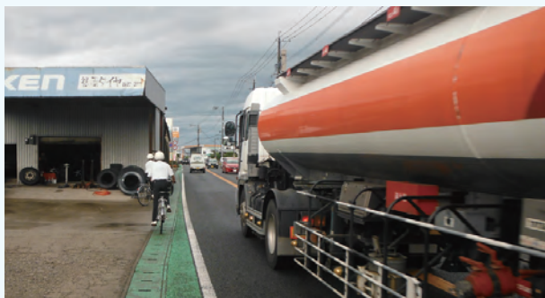
路肩が狭く、大型車が自転車を避けて走行している状況
