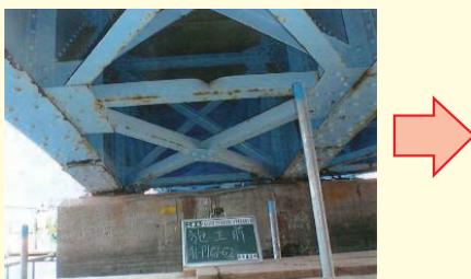
塗装の塗り替えによる橋梁の長寿命化 (国道 388 号美国橋)
