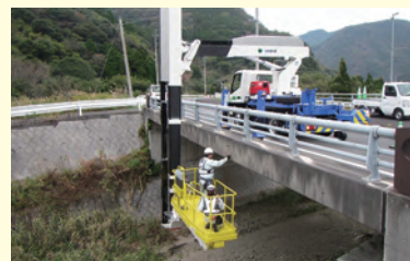
橋梁の詳細点検
