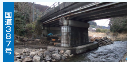
国道387号 老朽化した橋脚の補修
