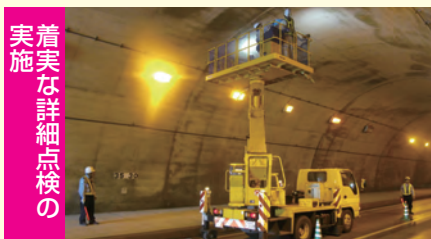
トンネルの詳細点検
