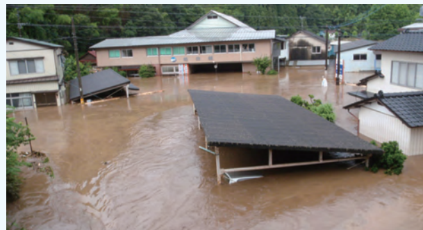
はん濫により市街地の多くの家屋が浸水（玉来川：竹田市）
