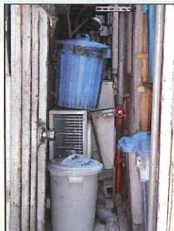
吹き出し口が塞がった室外機
